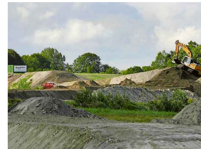
De geluidswal bij Menaam in aanbouw. Foto: Catrinus van der Veer
